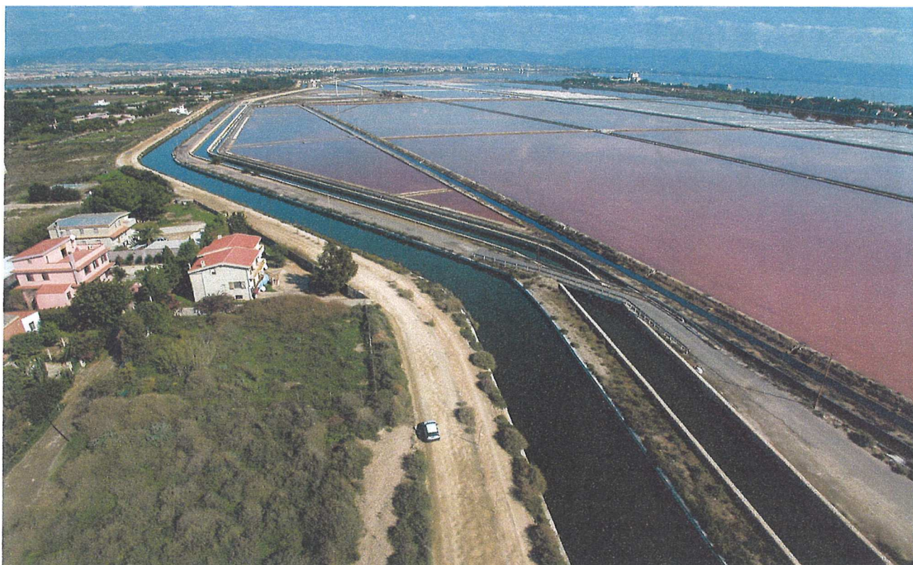
Il canale di gronda corre intorno al Molentargius intercettando tutte le immissioni
